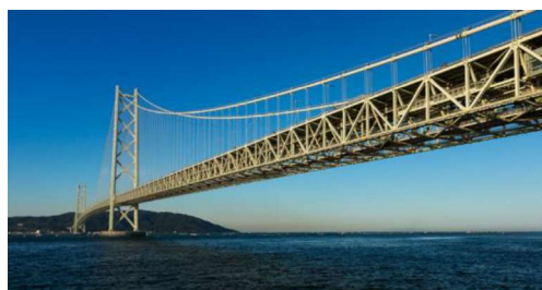
明石海峡大橋
