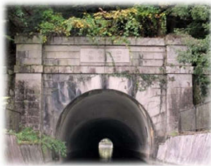
第三トンネル東口
