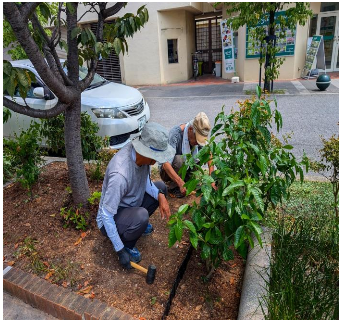
根止めプレート打ち込み
